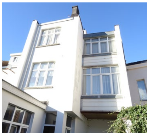
Façade arrière, avant les travaux
