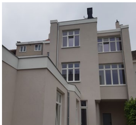
Façade arrière, après les travaux : isolation des façades, remplacement des châssis, rénovation des corniches et toitures
