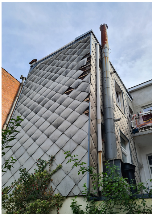
Façade arrière, avant les travaux.
