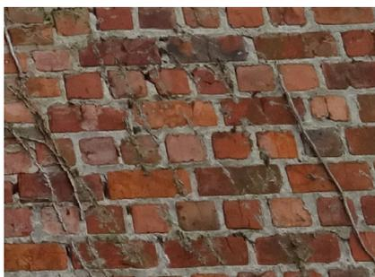
Prévoir un rejointoiement des briques. S'ils s'abîment et s'effritent, l'eau pénètre plus facilement dans les murs.
